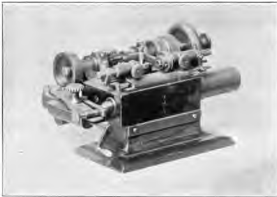
Fig. 11.—Staff Turning Lathe (Vander Woerd Pattern.)
